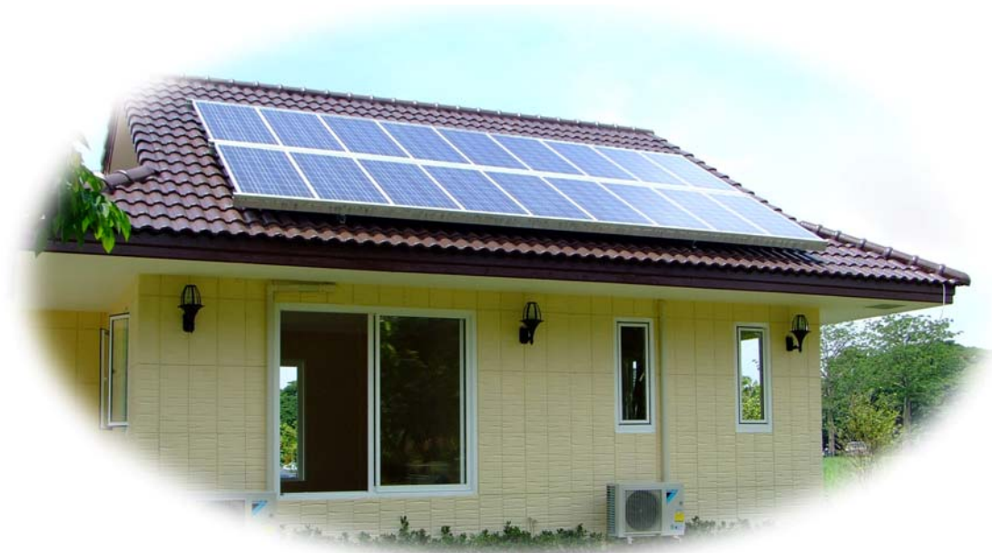
รูปที่ 2-7 ตัวอย่างการติดตั้งระบบผลิตไฟฟ้าด้วยพลังงานแสงอาทิตย์เชื่อมต่อสายส่ง ณ วังสวนจิตรลดา ดำเนินการโดยกรมการพลังงานทหาร ศูนย์อุตสาหกรรม ป้องกันประเทศและพลังงานทหาร สำนักปลัดกระทรวงกลาโหม
