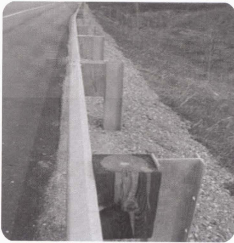
รูปที่ ๖ การติดตั้งราวกันอันตรายแบบรวมเหล็กผูกปูนเสาะแข็งข้างทางและเกาะกลาง
