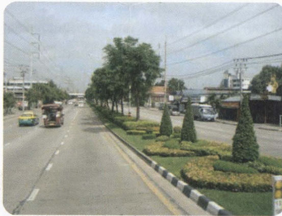
รูปที่ ๙ ระบบการยับยั้ง (Traffic Calming) แบบเกาะกลาง
