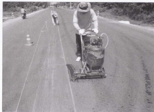
รูปที่ ๓๑ การเตรียมการตีเส้นจราจร
