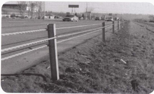
รูปที่ ๓ การติดตั้งราวกันอันตรายแบบเคเบิลข้างทาง
