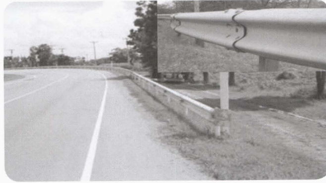
รูปที่ ๔ การติดตั้งราวกันอันตรายแบบราวเหล็กลูกฟูกบนเสาอ่อนข้างทาง
