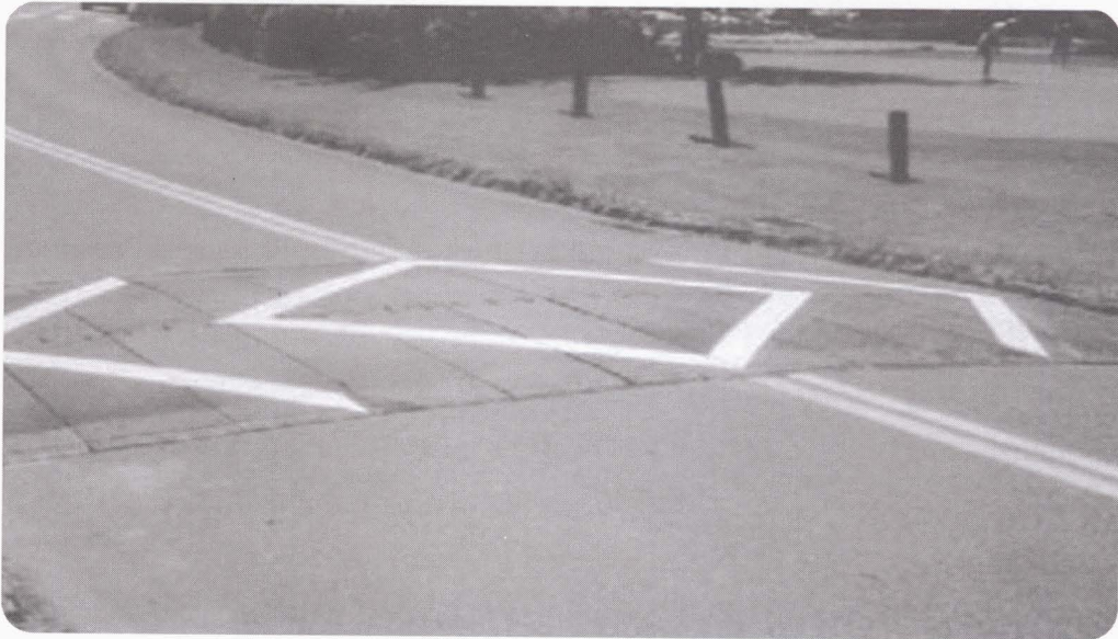
รูปที่ ๑๕ เนินชะลอความเร็วแบบโค้งพาราโบลา Parabolic Hump
