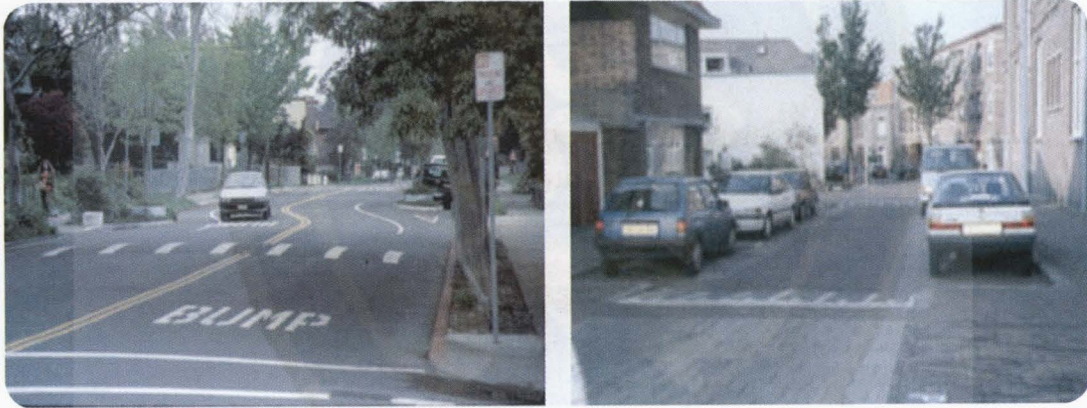
รูปที่ ๑๑ ระบบยับยั้งจราจร แบบเนินชะลอความเร็ว
