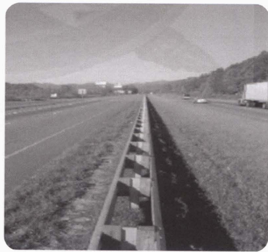
รูปที่ ๖ การติดตั้งราวกันอันตรายแบบรวมเหล็กผูกปูนเสาะแข็งข้างทางและเกาะกลาง
